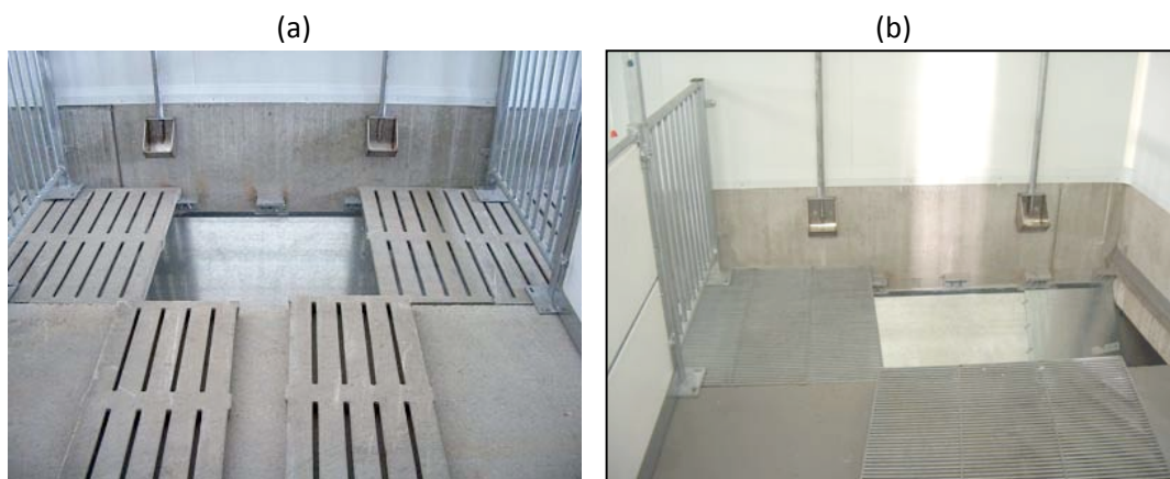
Figura 3. a) Suelo continuo de hormigón, enrejado de hormigón (HH); b) suelo continuo recubierto de resina epoxídica, enrejado metálico (RM).
